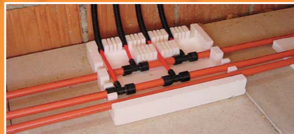
Registeranschlussbox mit Sammelrohranschluss für 2 Teilkreise
