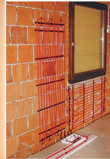
VOR-8 verlegt an der Innenseite der Außenwand
