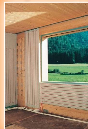
UNI-8 Wandheizplatten montiert auf der Holzunterkonstruktion
