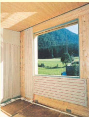
Uni-8 Wandheizplatten montiert auf der Holzunterkonstruktion
