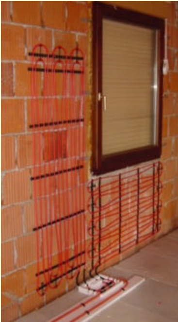
VOR-8 verlegt an der Innenseite der Außenwand
